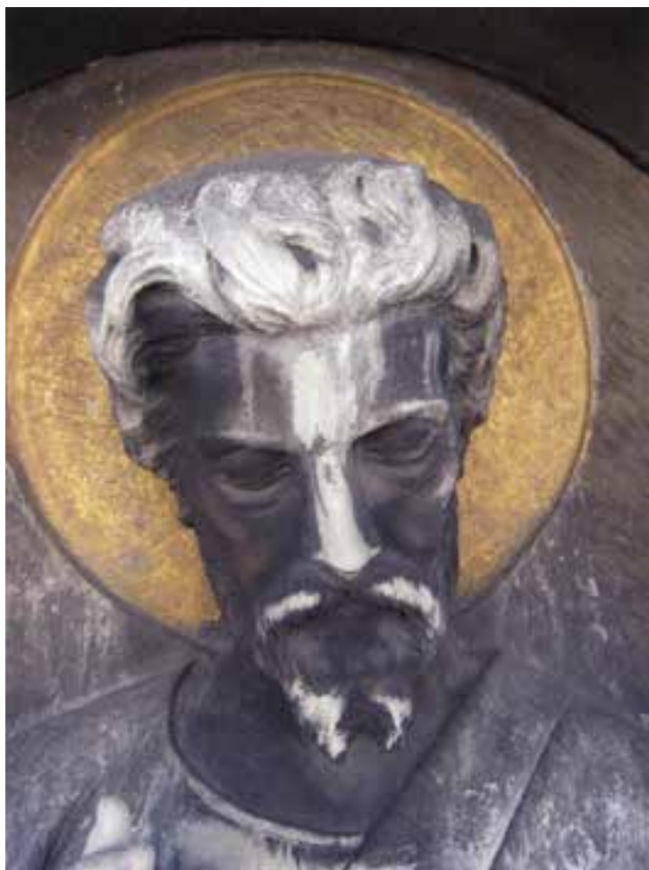
VIII/9 – Детаљ са статуе једног од светитеља на главној фасади цркве пре реставрације
