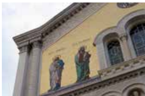
Детаљи с главне фасаде
