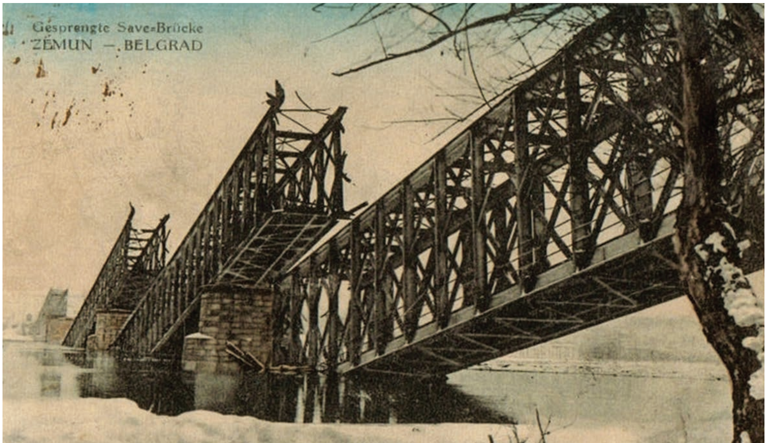
Le tre fasi di demolizione del ponte ferroviario sulla Sava, luglio-dicembre 1914 (Archivio di Serbia, Raccolta di fotografie) Три фазе рушења железничког моста на Сави, јул-децембар 1914. године. (Архив Србије, Збирка фотографија)
