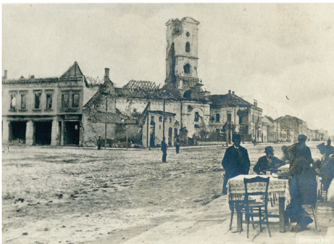
La chiesa e gli edifici distrutti nel bombardamento austro-ungarico di Šabac, 1914 (Archivio di Serbia, MID, album di guerra di Rista Marjanović) Црква и зграде срушене у аустроугарском бомбардовању Шапца, 1914. године (Архив Србије, МИД, Ратни албум Ристе Марјановића)
